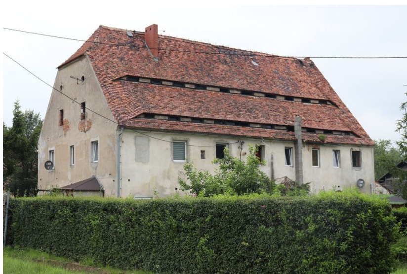
Ryc. 26: Budynek mieszkalny zarządcy majątku w Tylicach.
